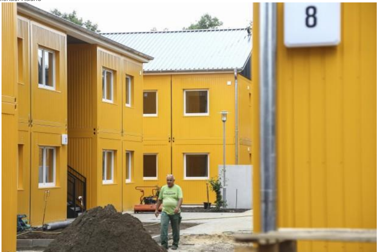
Muster für Farmsen? Die neue Flüchtlingsunterkunft in der Rahlstedter Straße kurz vor der Fertigstellung
