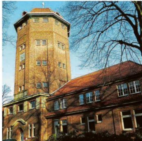
Der Wasserturm könnte als Begegnungsstätte genutzt werden.
